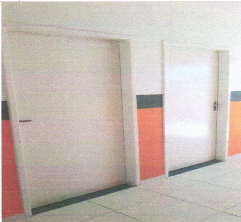
Foto 07 –REVESTIMENTO CERÂMICO PARA PAREDES INTERNAS COM PLACAS TIPO ESMALTADA EXTRA DE DIMENSÕES 33X45CM APLICADAS EM AMBIENTES DE ÁREA MAIOR QUE 5M2 A MEIA ALTURA DAS PAREDES. AF_06/
