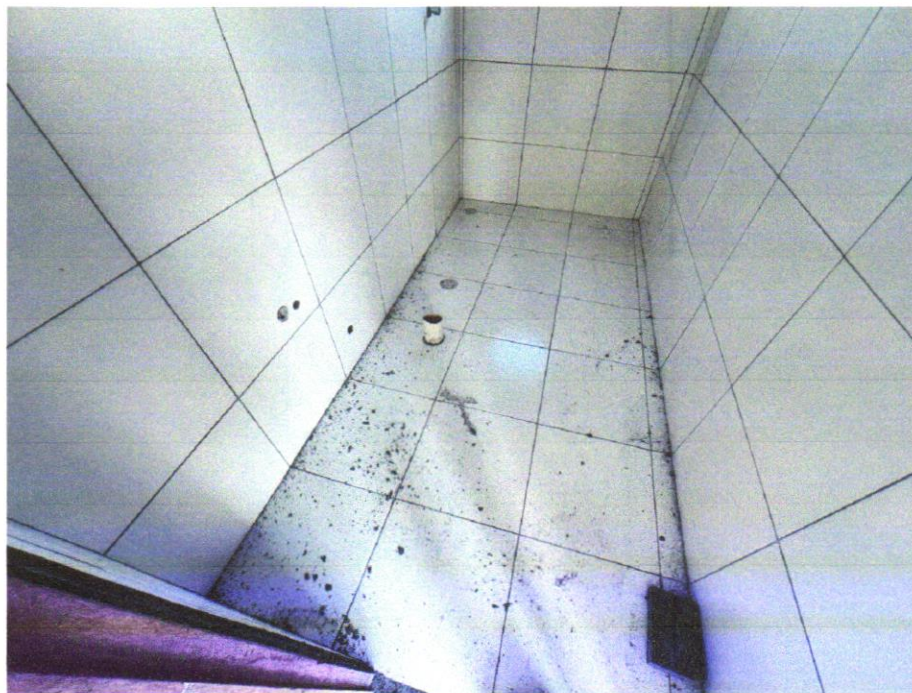
Foto 01 - REVESTIMENTO CERÂMICO PARA PISO COM PLACAS TIPO ESMALTADA EXTRA DE DIMENSÕES 45X45 CM APLICADA EM AMBIENTES DE ÁREA MAIOR QUE 10 M2. AF_06/2014
